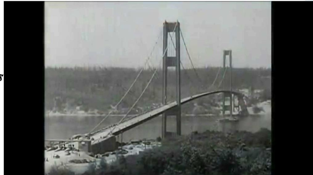
Das Auftreten dieser Umstände nennt man Resonanz. Sind im System nicht ausreichende Dämpfungen vorhanden, führt das zur Resonanzkatastrophe, die Bauteilversagen bedeutet.
